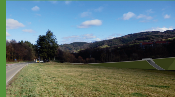
Stöckenhöfe A mit geplantem Rückhaltebecken
